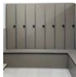
Verblendung mit vorgebauter Sitzbank
