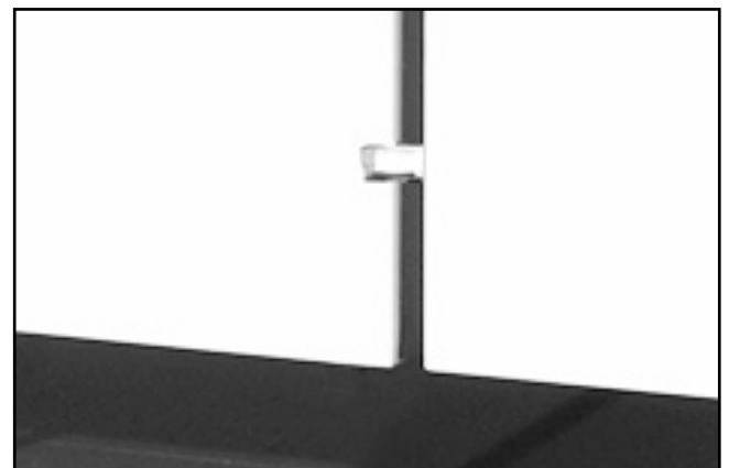
untere Türluft (Ansicht Kabine innen)
