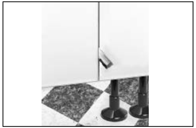
untere Türluft (Ansicht Kabine innen)
