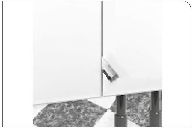
untere Türluft (Ansicht Kabine innen)
